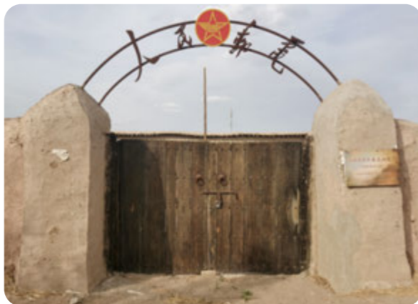
☆ 图十二 苦水巡房大门
