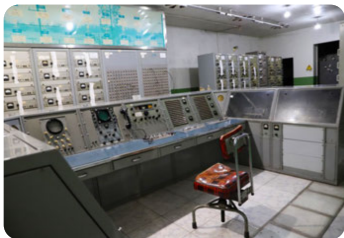
☆ 图七 四川国际电台旧址的收信监控台
