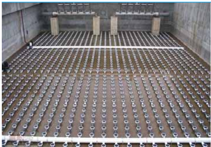
图表13：曝气池里分布的曝气头
